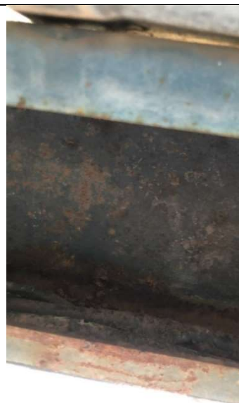
Emenda da Alimentação dos Equipamentos das Salas 1, 3 e 5
