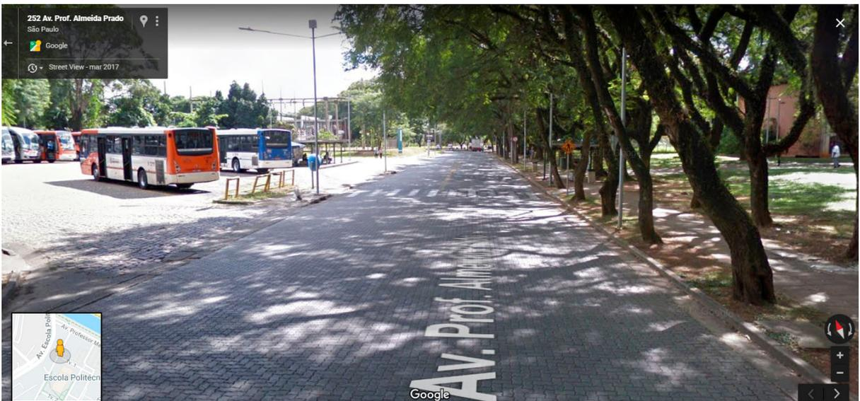
Figura 3: Piso em bloco de concreto intertravado na cidade Universitário USP, Av. Prof. Almeida Prado. Observe que há um terminal de ônibus ao lado da via, demonstrando que é possível transitar elevadas cargas nesse tipo de revestimento. Fonte: Google Maps.
