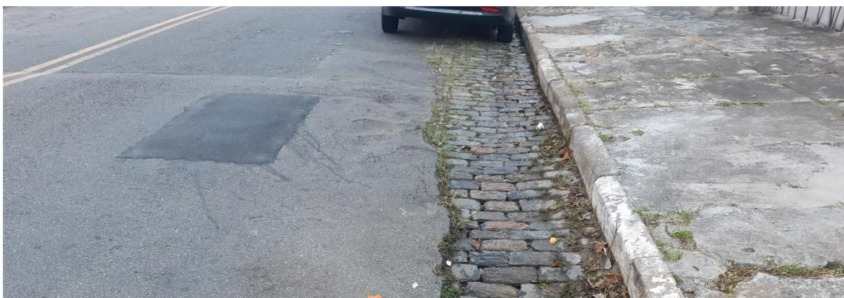
Figura 5: Possibilidade de se manter piso existente (paralelepípedo) demarcando área de estacionamento e pavimento asfáltico onde se encontra as faixas de tráfego. Foto: Yara Baiardi, 2018.
