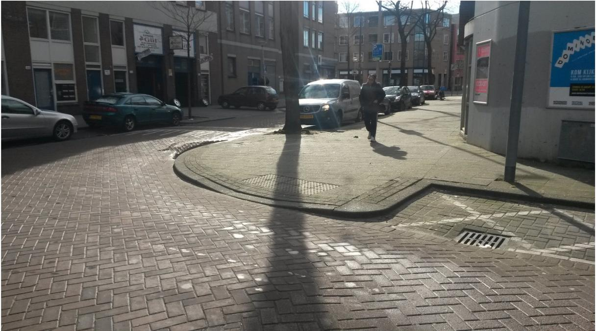
Figura 6: Alargamento da calçada nos cruzamentos para aumento da segurança viária na travessia do pedestre. Observe na imagem, o rebaixamento da guia e na diferenciação de piso: calçada, estacionamento e rua. Fonte: Yara Baiardi, 2016.
